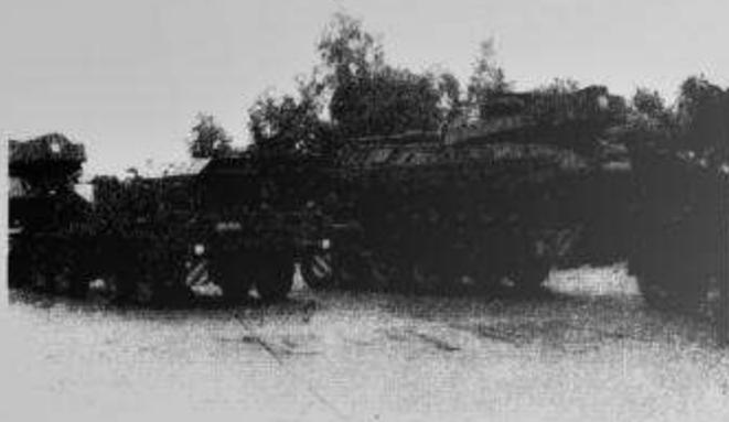
Der Schwerlasttransporter SLT 50/2, genannt "Elefant", wurde 1978 in die Bundeswehr eingeführt und ist in mehreren Exemplaren bei InstBtl 120 verfügbar.
