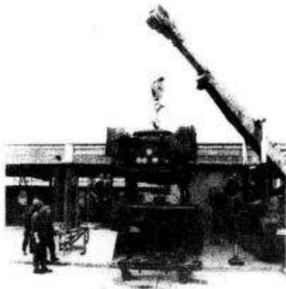
Triebwerkwechsel mit 13 to-Kran
